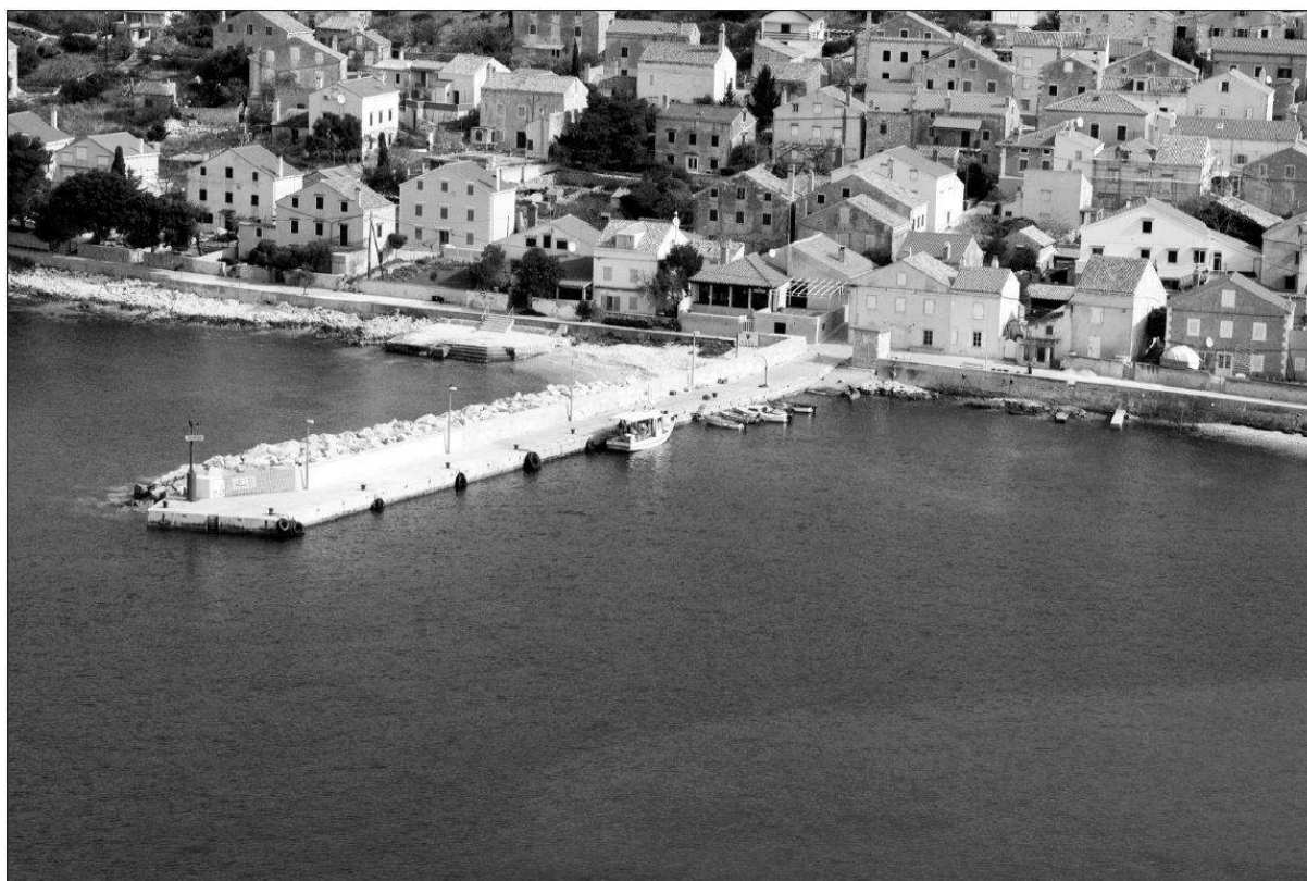
Slika 1: Pogled na postojeći pristan/lukobran u luci Unije
